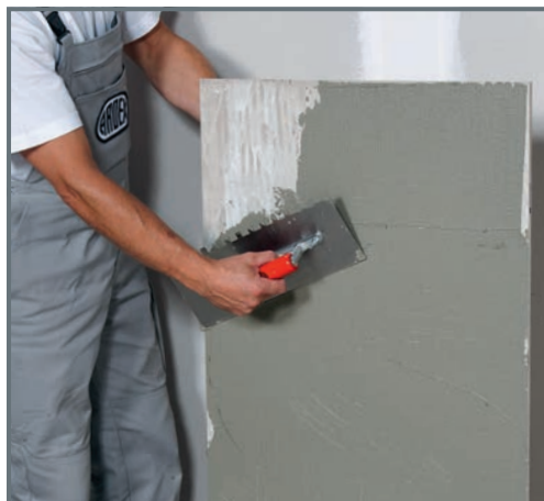
Tuplaliimauksessa kiinnityslaasti levitetään myös laatan takapintaan.
