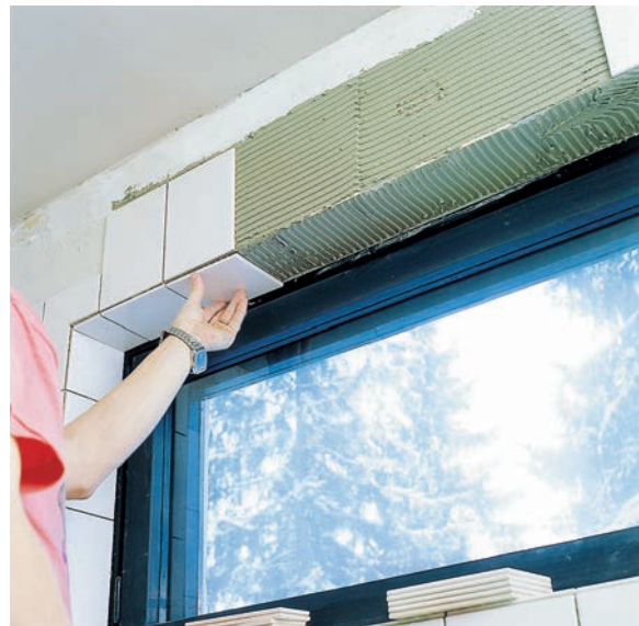
ARDEX X 77 -kiinnityslaasti on täysin valumaton, jolloin hankalienkin paikkojen laatoitus ilman tukia on mahdollista.
