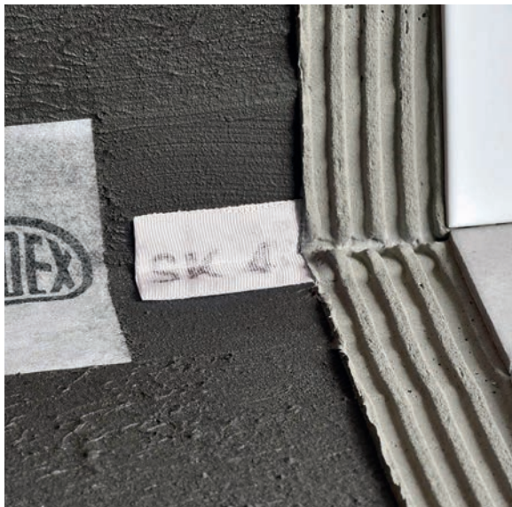
ARDEX SK 4 PROTECT -viiltosuojanauha suojaa vedeneristystä silikonia uusittaessa ja estää silikonin 3-pistetartunnan.
