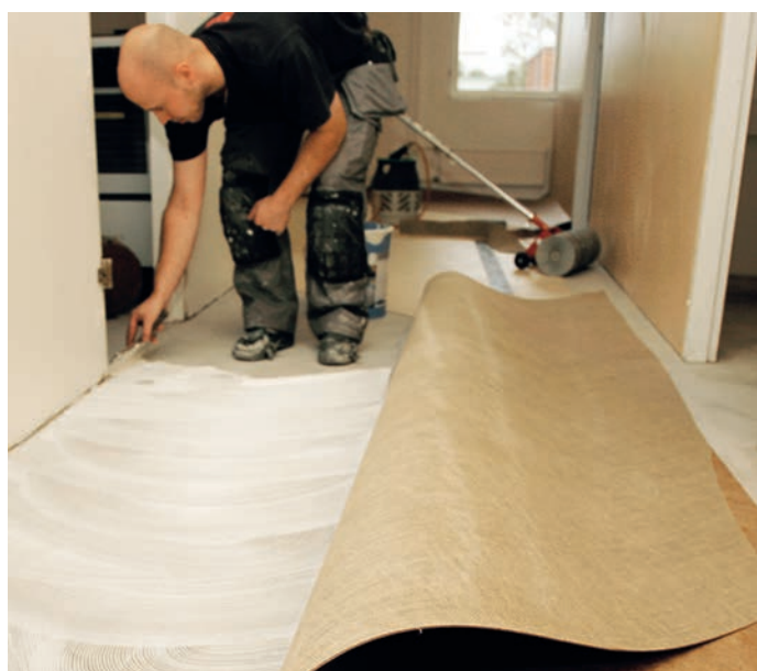
Plastkattematerjalid ja linoleumid kinnitatakse ARDEX M1 klassifikatsiooniga katteliimidega.
