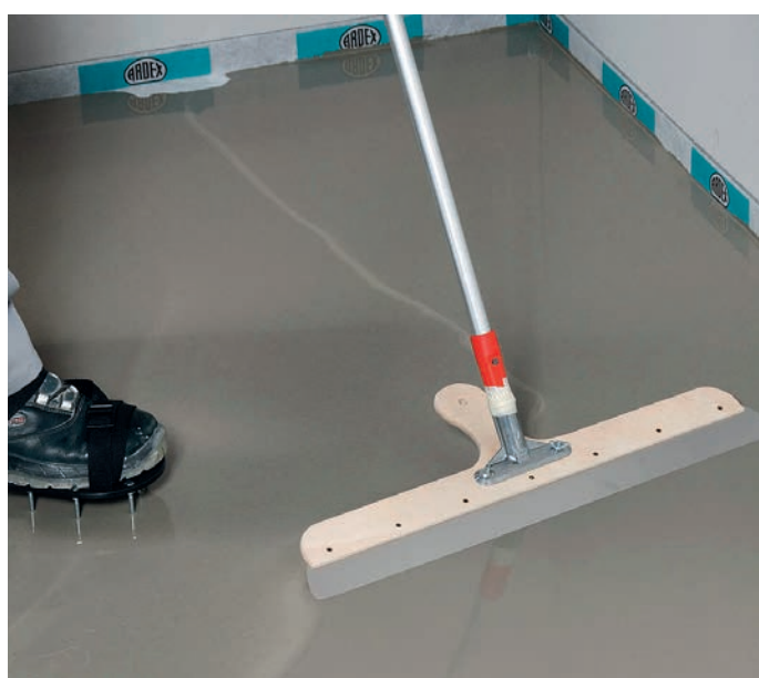
ARDEX 40 ja ARDEX K 33 on M1 klassifikatsiooniga tasandussegud, millest saadakse kergesti valmis aluspind kattematerjalile.
