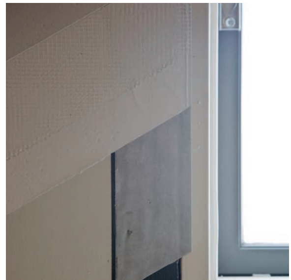
Seinäpintojen tasoitus tiivistyskerroksen päälle tehdään ARDEX F 5 -tasoitteella ja BU-R -verkkolla.
