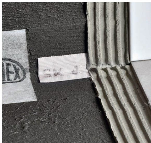
ARDEX SK 4 PROTECT är en självhäftande skyddsband för skydd av tätskikt vid borttagning av silikonfog.
