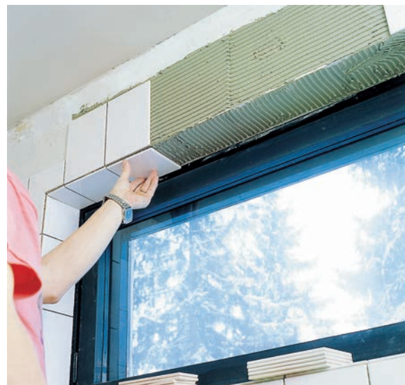
ARDEX-plattsättningsbruk är helt droppfasta och även krävande ställen kan därför plattläggas utan extra stöd.
