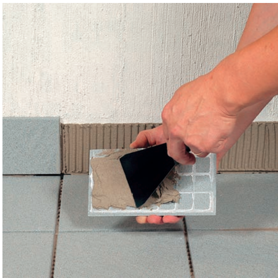
Tarvittaessa laasti levitetään myös laatan takapintaan, jotta saadaan täysi laastipeitto.
