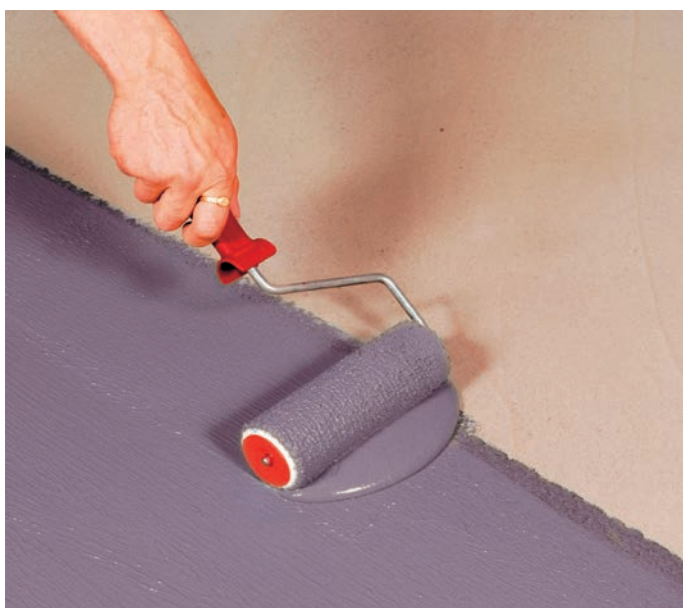
ARDEX 8+9 tai 8+9 LW -vedeneriste telataan alustaan voimakkaasti painaen, jotta saadaan paras mahdollinen tartunta.
