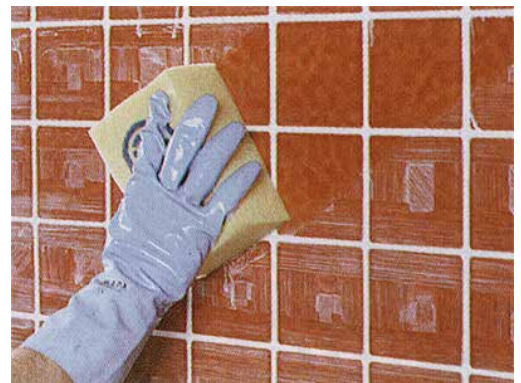
Epoksisauaman muotoilu tehdään pesusienellä. Jälkikostutusta ei tarvita.
