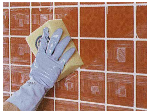
Epoksüvuugi viimistlemine tehakse pesukäsna. Järelniisutust ei ole vaja teha.
