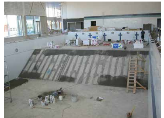
Seinälaatat on kiinnitetty ARDEX WA -epoksiliimalla.
