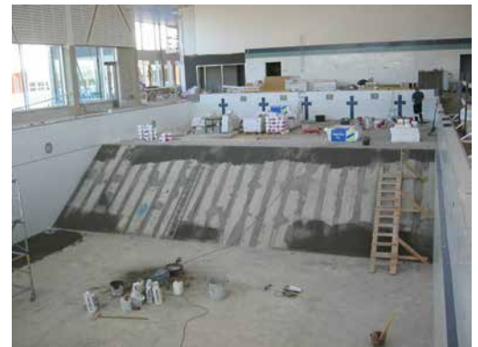
Seinälaatat on kiinnitetty ARDEX WA -epoksiliimalla.
