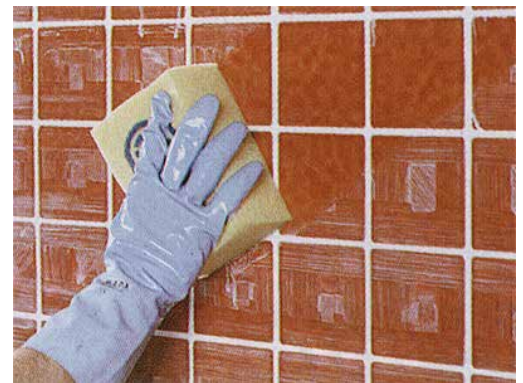
Epoksisauaman muotoilu tehdään pesusienellä. Jälkikostutusta ei tarvita.
