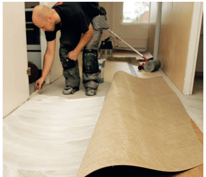
Muovipäällysteet ja linoleumit kiinnitetään ARDEX M1-luokitelluilla päällysteliimoilla.
