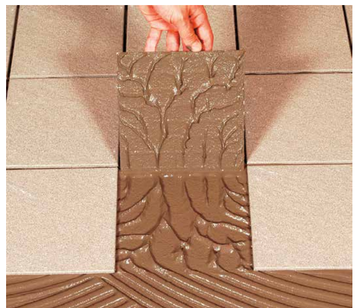
ARDEX X 90 Outdoor -kiinnityslaasti mahdollistaa alustan ja laatan väliin 100 % tartunnan. Näin välttyään pakkasvaurioilta.
