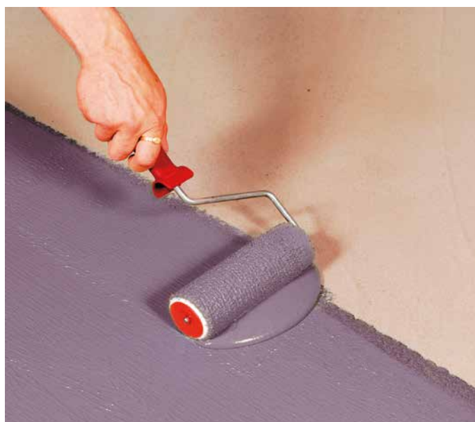
ARDEX 8+9 tai 8+9 LW -vedeneriste telataan alustaan voimakkaasti painaen, jotta saadaan paras mahdollinen tartunta.
